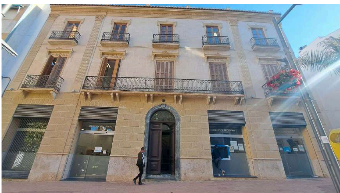
Sede de Mancomunidad y Aguas y Servicios (EL FARO)
