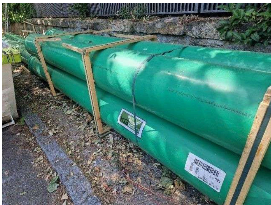
Acopio tubería KG2000
