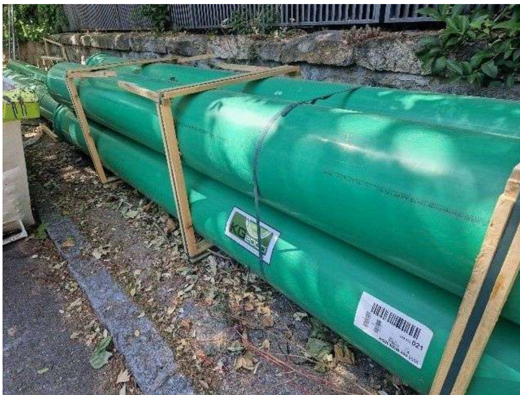
Acopio tubería KG2000
